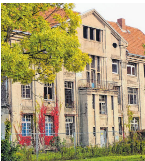
Erhaltenswert: Die Fassade der Schokoladenfabrik stammt aus dem Kaiserreich und ist die letzte ihrer Art in der Kurstadt.
